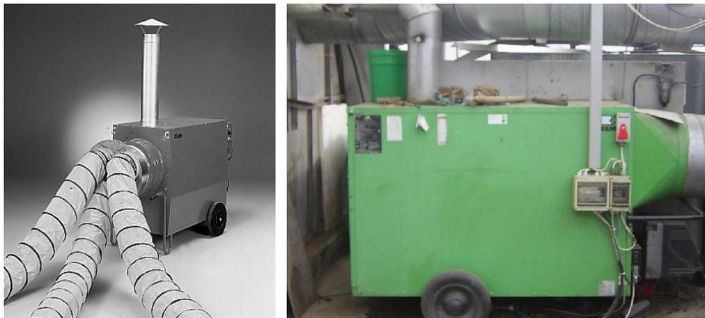
**Abbildung 67:** fahrbarer Warmlufterzeuger links aus (4); rechts im Einsatz
