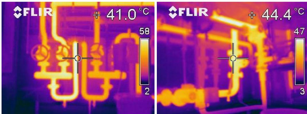
Abbildung 33 a)-d): Infrarotthermografie (Kohlekessel /Pufferspeicher/Wärmeverteilungen)
