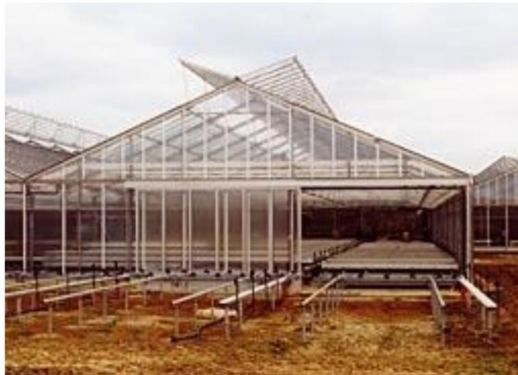
**Abbildung 48:** Breitschiffbauweise
