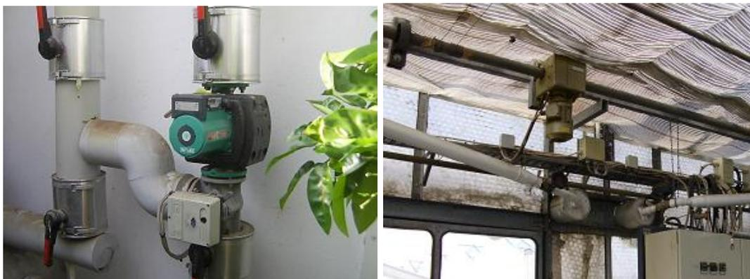
**Abbildung 87:** Praxisbeispiel für Aktoren (Heizungsmischer, Energieschirmantrieb)
