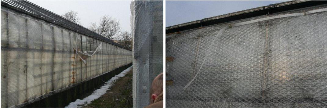
**Abbildung 31:** beschädigte Noppenfolien
