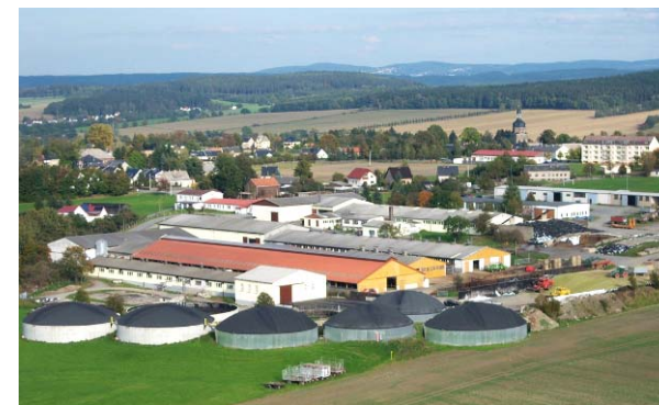
Theuma-Neuensalz, Biogasanlage mit Mikrogasnetz und 2 Satelliten-BHKW Foto: AG Theuma-Neuensalz
