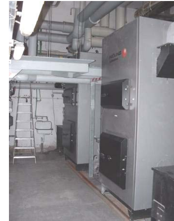
Heizkesselanlage 2 x 500 kW
