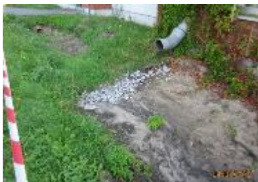
Ausspülung an Fallrohr DN 300
