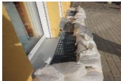
Wassereintritt über Lichtschächte in ein Kellergeschoss
