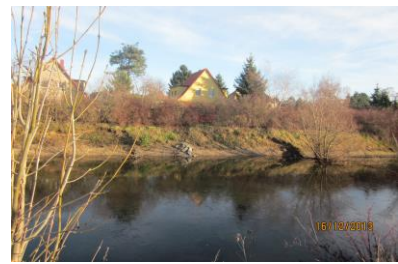
Versickerungsanlage bei fehlender Instandsetzung
