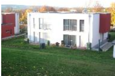
Abfluss von der Wiese eines Nachbargrundstücks führte zum Wassereintritt in ein Kellergeschoss
