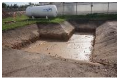
Kolmatierte Sohle einer Versickerungsanlage im Bau
