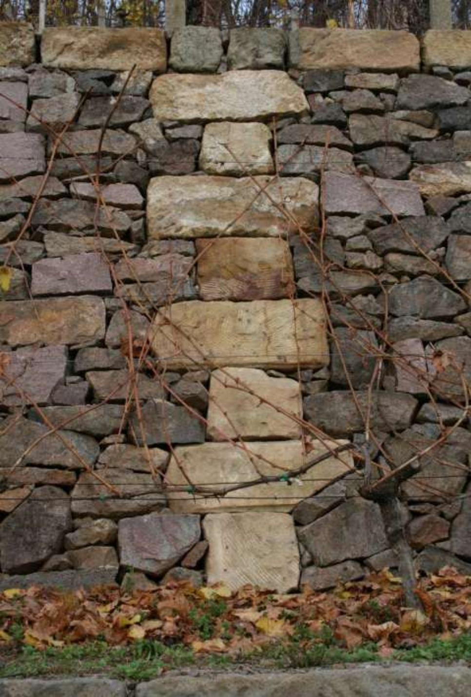
„Pfosten“ aus quaderförmigen Läufern und Bindern im Abstand von 5 – 8 m zur Verbesserung der Stabilität von Bruchsteintrockenmauern
