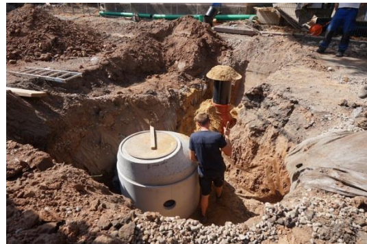
Abb.: Einbau von Entwässerungsschächten
