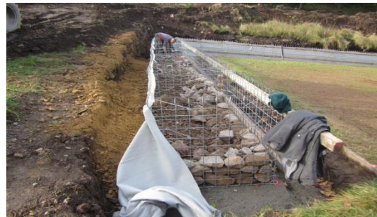
Abb.: Einbau von Geotextil hinter Gabionen
