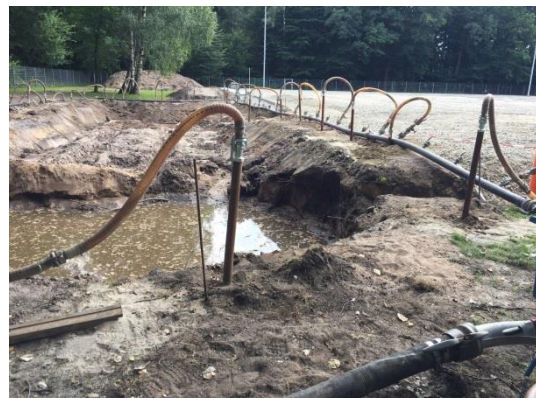
Abb.: geschlossene Wasserhaltung
