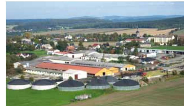
Theuma-Neuensalz, Biogasanlage mit Mikrogasnetz und 2 Satelliten-BHKW Foto: AG Theuma-Neuensalz
