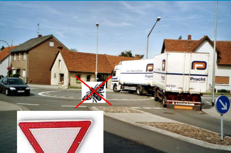
Der “Mini” passt dorthin, wo es für einen Kompaktkreisel mit LKW-tauglicher Spur und großer Mittelinsel zu eng wird.
